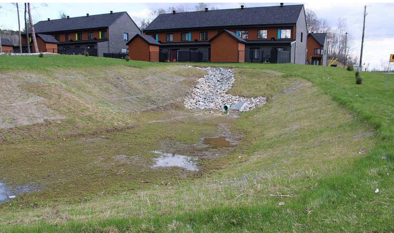
Zbiornik retencyjny zbiera deszczówkę z dachów i parkingu małego osiedla mieszkaniowego, fot. Normand Lemieux CC BY-SA 4.0 Wikimedia Commons
